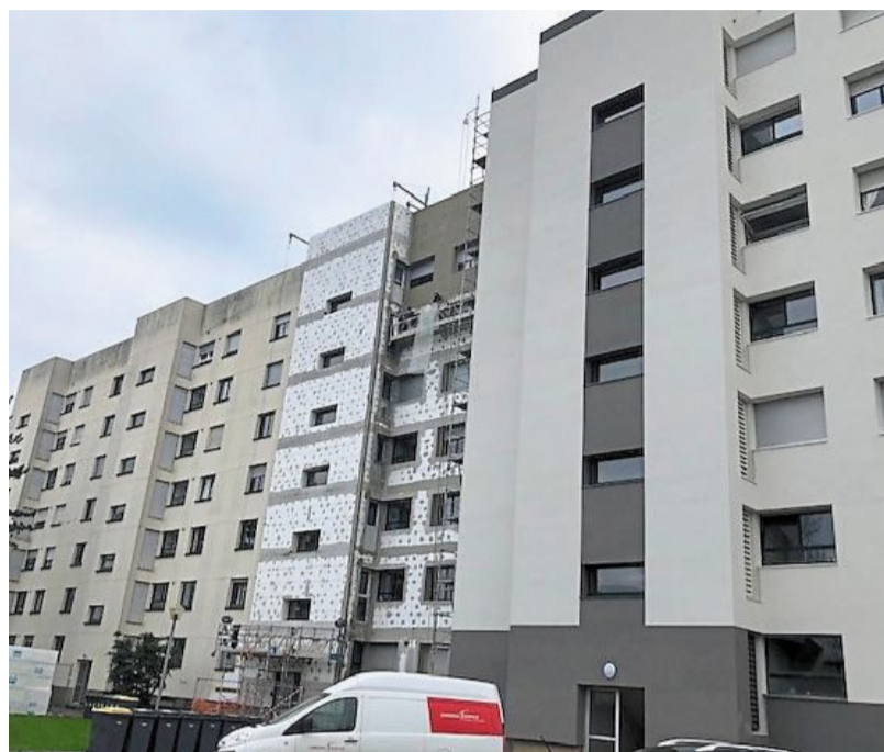
On voit ici les trois phases des travaux d'isolation thermique des façades extérieures : de gauche à droite, avant, pendant et après. | PHOTO : OUEST-FRANCE
